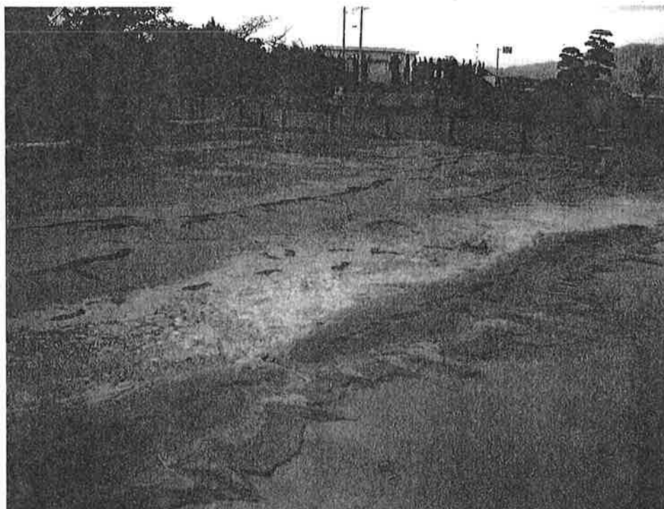
写真1. 地震直後の噴砂状況（その1）. 2000年10月6日.
